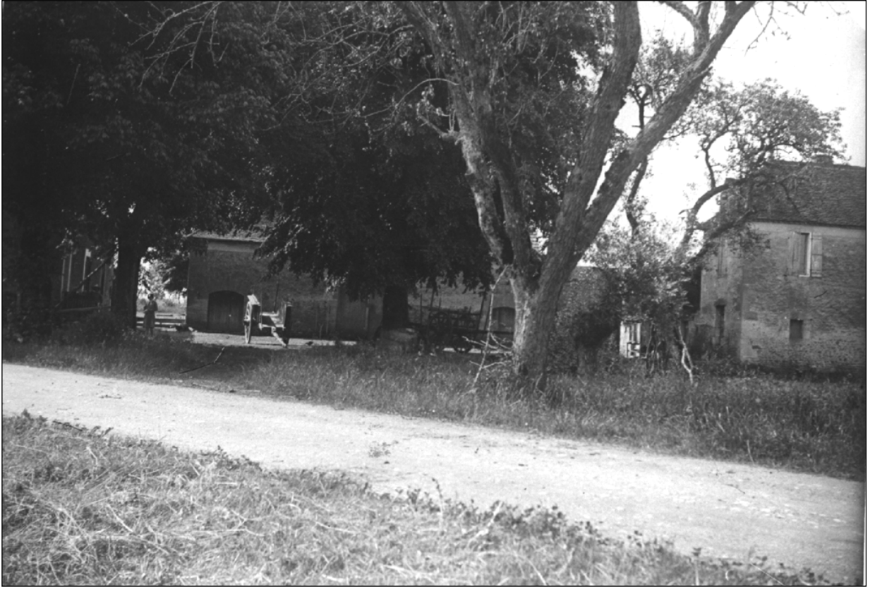
Le Besselance - La cour vue de la route (1932)
